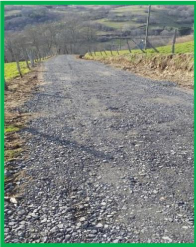
*Les employés communaux ont effectué le débroussaillage, l'abattage de quelques petits arbres, le nettoyage du fossé et la remise en état du chemin de la Cabane. De gros travaux de réfection : élargissement, dégazonnage, saignées pour écoulement d'eau... ont également été effectués sur le chemin de Chabagnol.*
